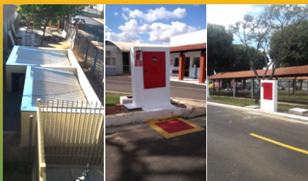
Execução do Projeto Bombeiro
