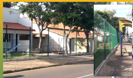
Substituição parcial do alamedado em torno da instituição por Gradil galvanizado
