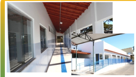
Finalização da reforma do Bloco Infantil
